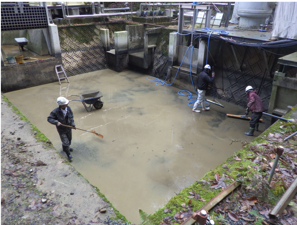
沈砂池清掃 沈砂池 土砂撤去状況
