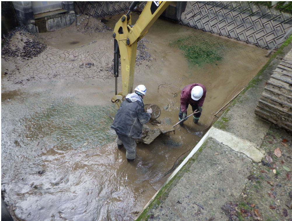
沈砂池清掃 沈砂池 土砂撤去状況
