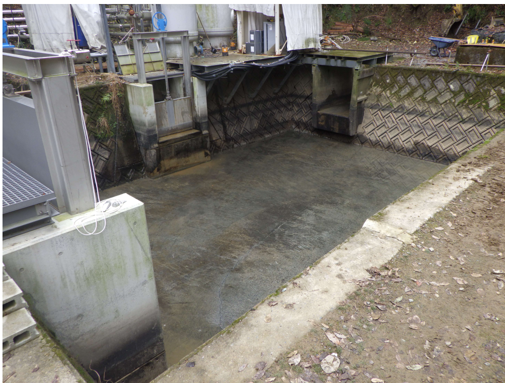
沈砂池 土砂撤去完了
