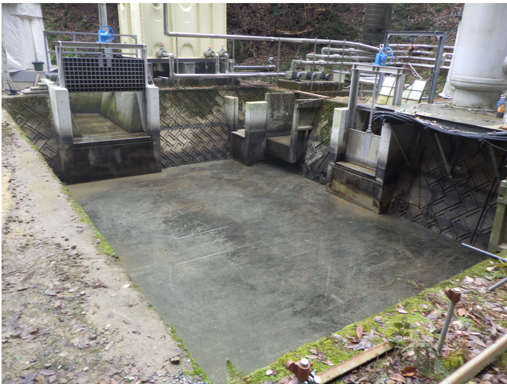
沈砂池 土砂撤去完了
