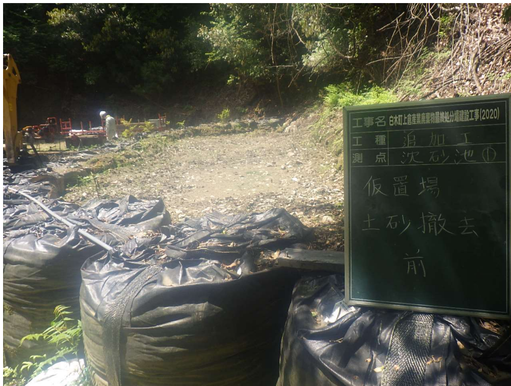
沈砂池清掃 仮置部 土砂撤去前
