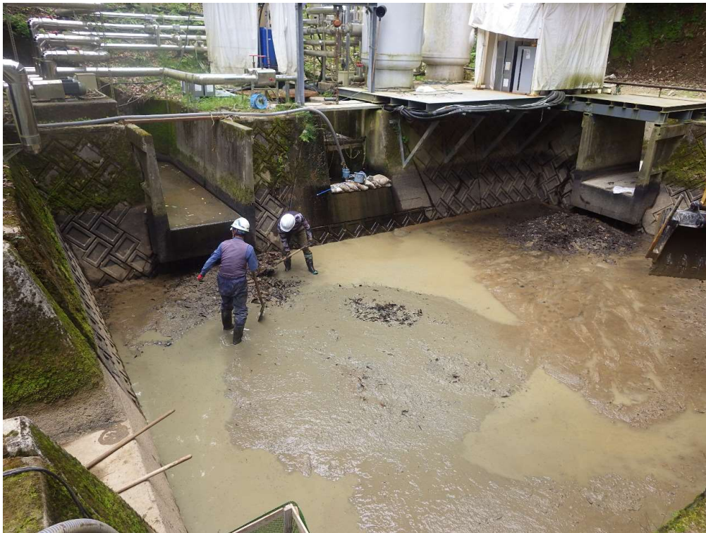
沈砂池清掃 沈砂池 土砂撤去状況
