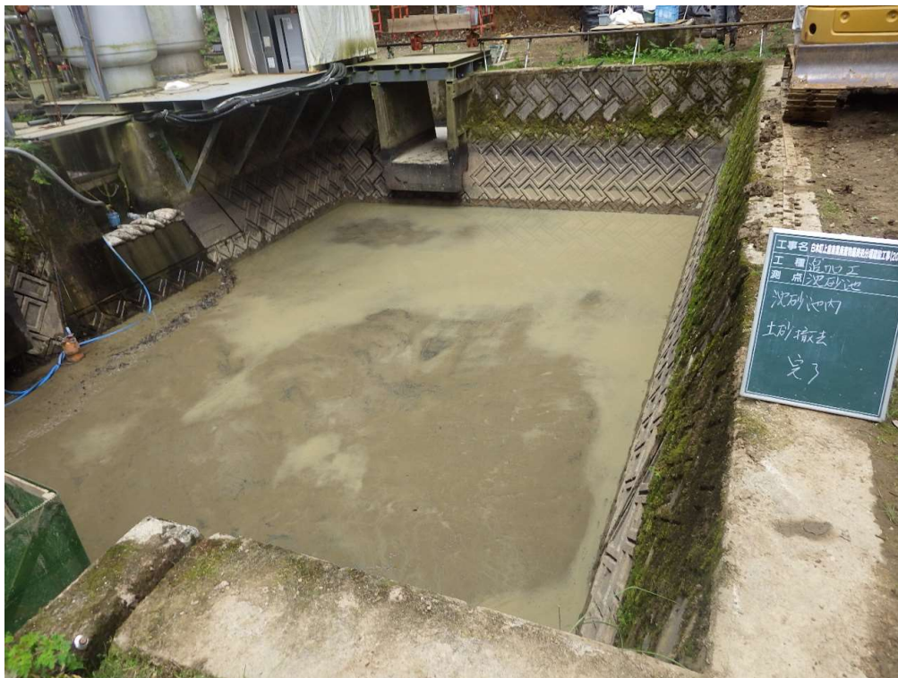
沈砂池 土砂撤去完了
