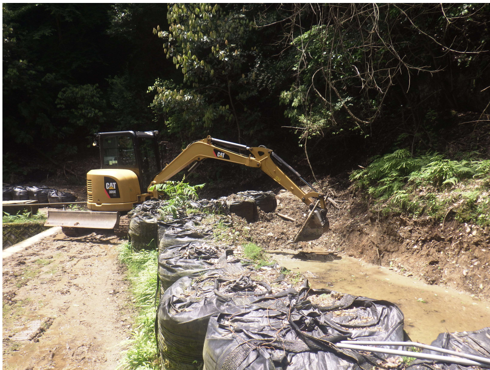
沈砂池清掃 沈砂池 土砂撤去状況
