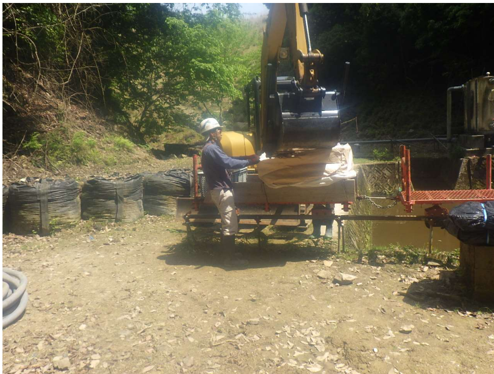
沈砂池清掃 仮置部 土砂撤去状況
