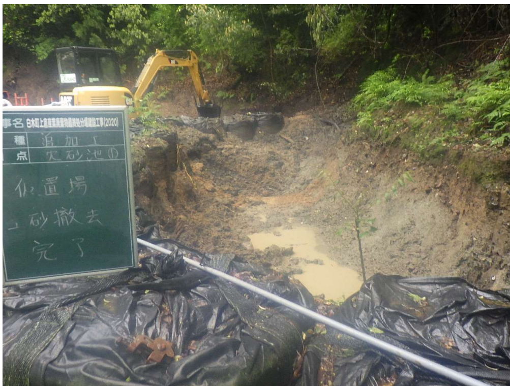
沈砂池清掃 仮置部 土砂撤去完了
