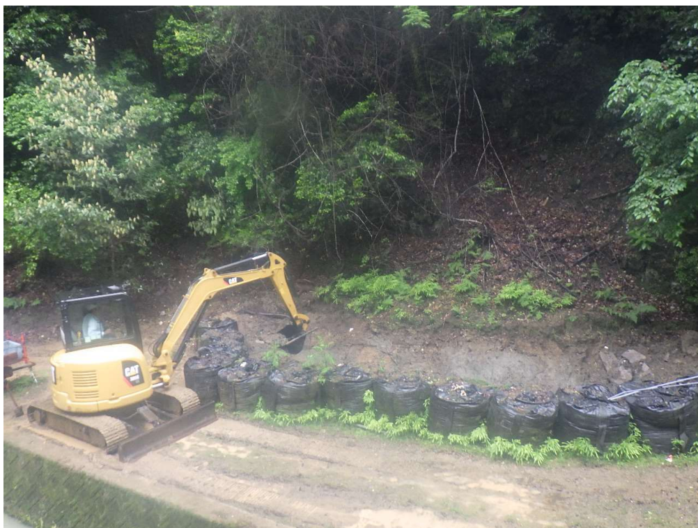
沈砂池清掃 仮置部 土砂撤去状況
