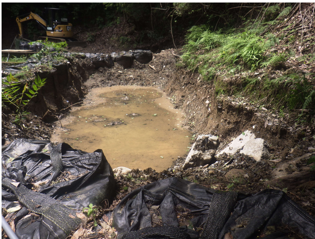
沈砂池清掃 沈砂池 土砂撤去状況
