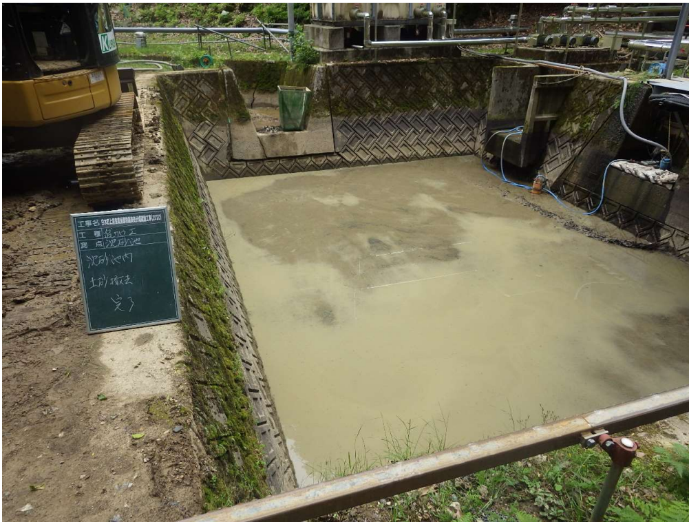
沈砂池 土砂撤去完了
