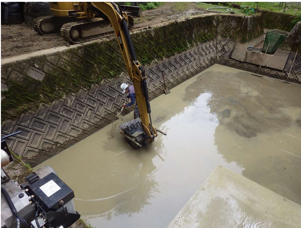
沈砂池清掃 沈砂池 土砂撤去状況
