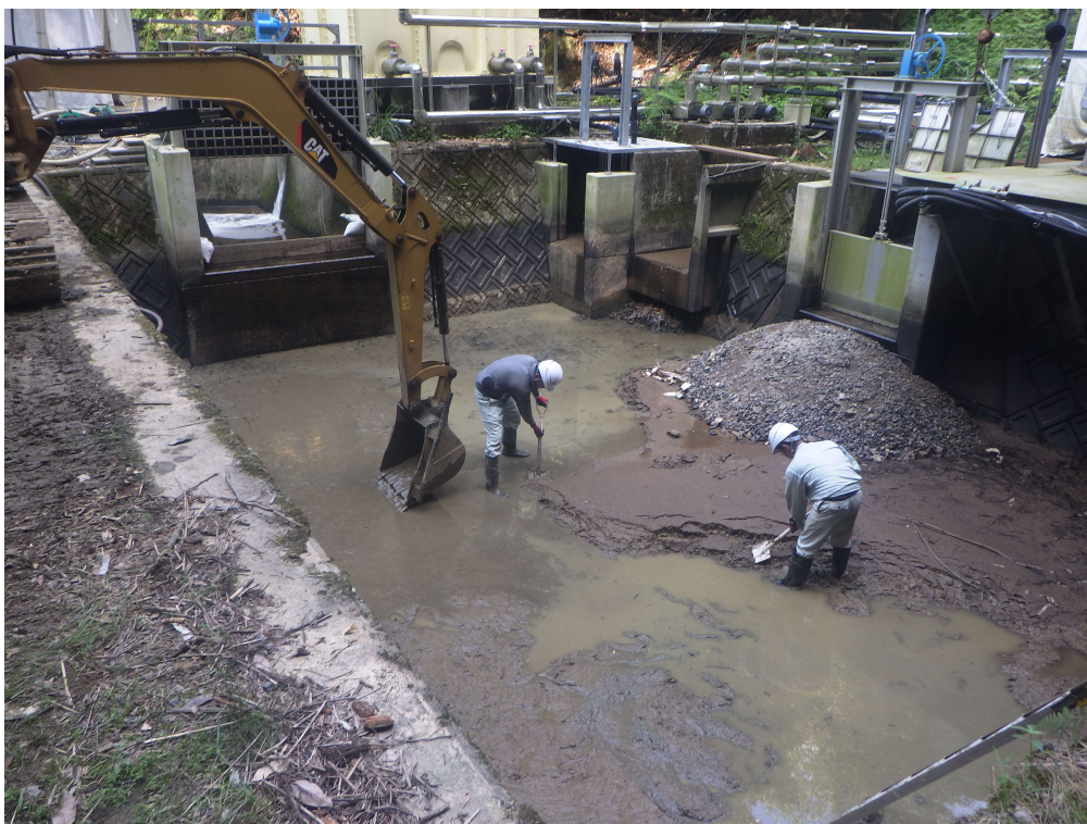
沈砂池清掃 沈砂池 土砂撤去状況
