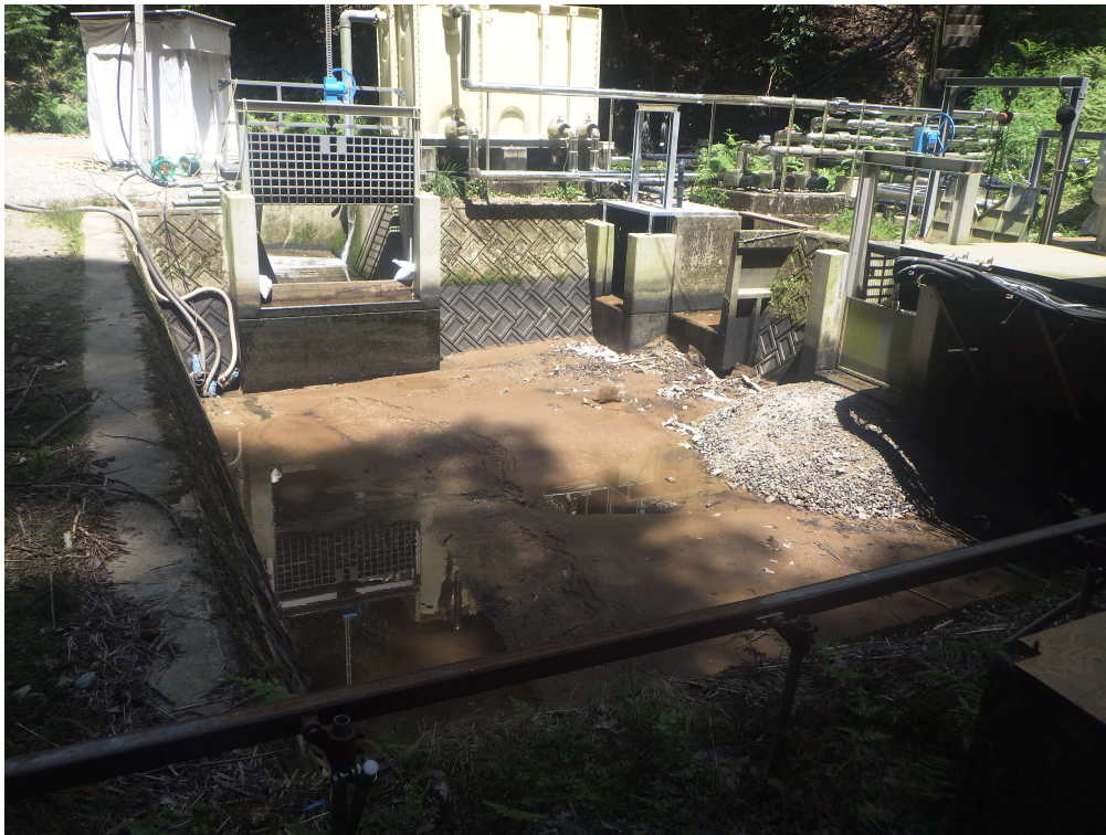
沈砂池 土砂撤去前
