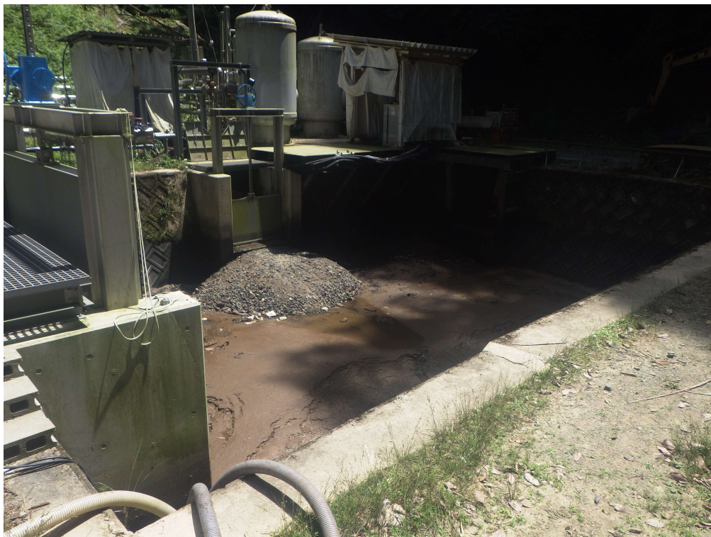
沈砂池 土砂撤去前
