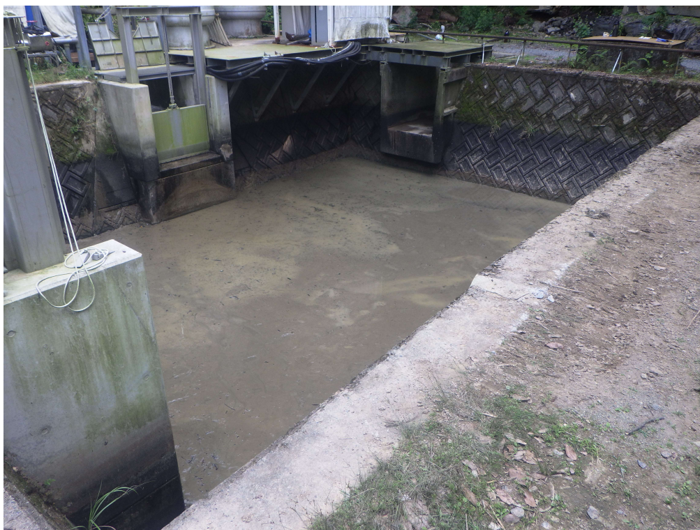
沈砂池 土砂撤去完了
