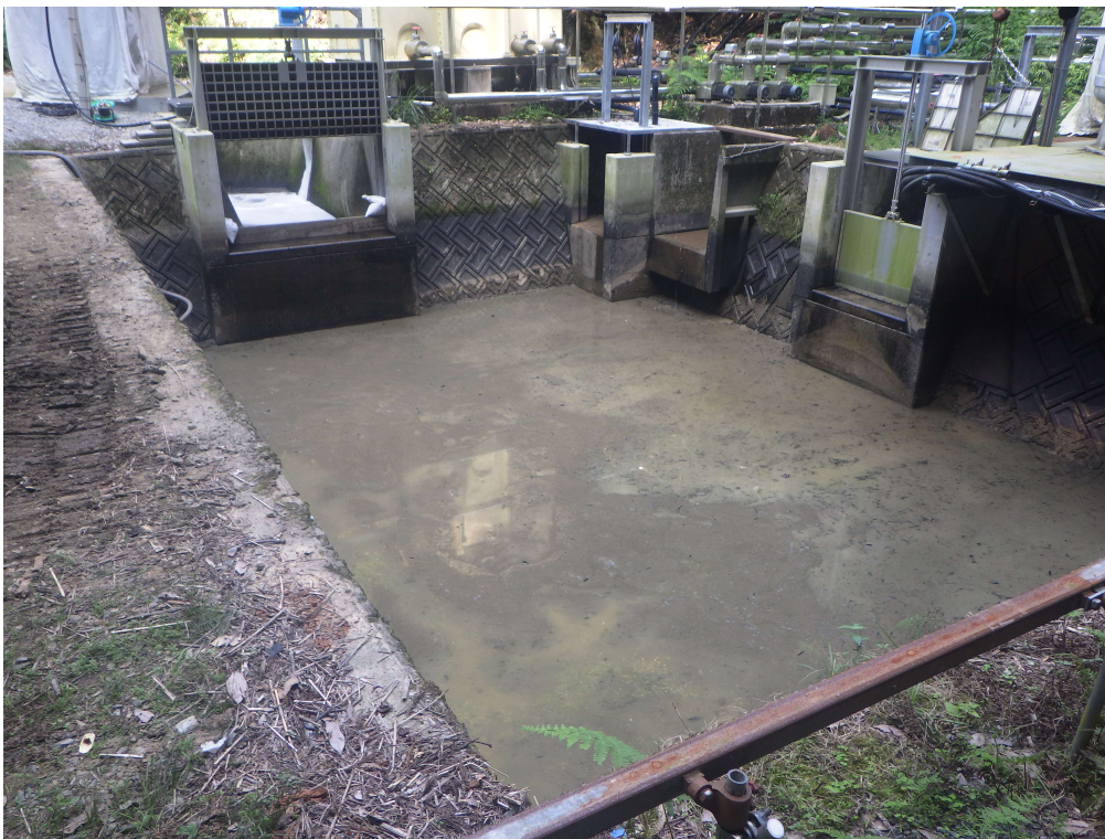
沈砂池 土砂撤去完了
