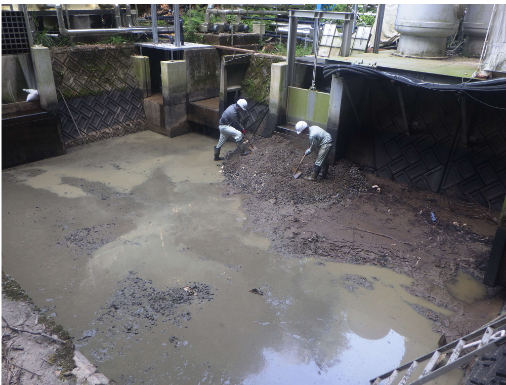
沈砂池清掃 沈砂池 土砂撤去状況
